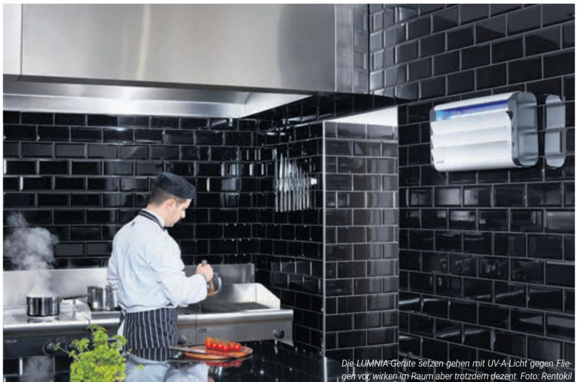
Die LUMNIA-Geräte setzen gehen mit UV-A-Licht gegen Fliegen vor, wirken im Raum aber trotzdem dezent. Foto: Rentokil
